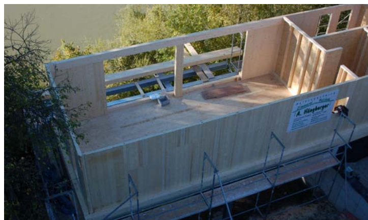
Der Ausblick Vier Höhen-Meter trennen Fluss und Wohnplateau. Die hausbreiten und giebelhohen Fertigteile aus Plattenspertholz wurden in der Zimmerei millimetergenau vorgefertigt. Gesamtkosten für 97 qm Wohn- und Nutzfläche: 230 000 €.
